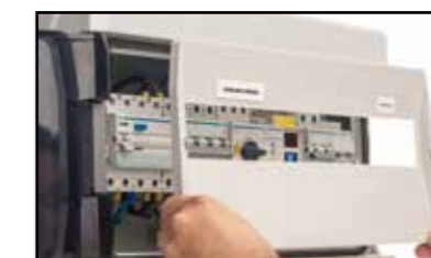
Odnímatelný krycí rámeček modulových přístrojů – urychluje instalaci
